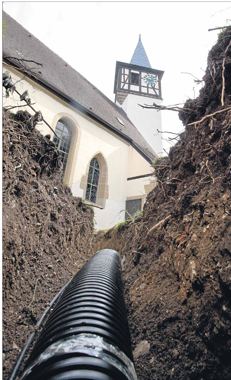
Die Erneuerung der Heizungsanlage ist fast abgeschlossen. Doch dies ist erst der Anfang der Kirchensanierung.
